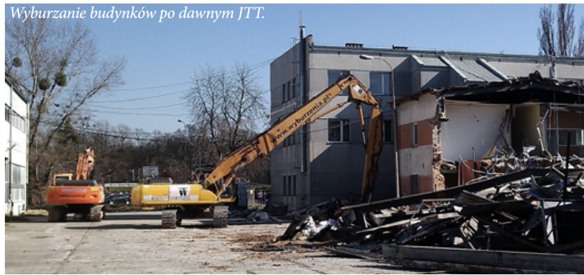
Wyburzanie budynków po dawnym JTT.
